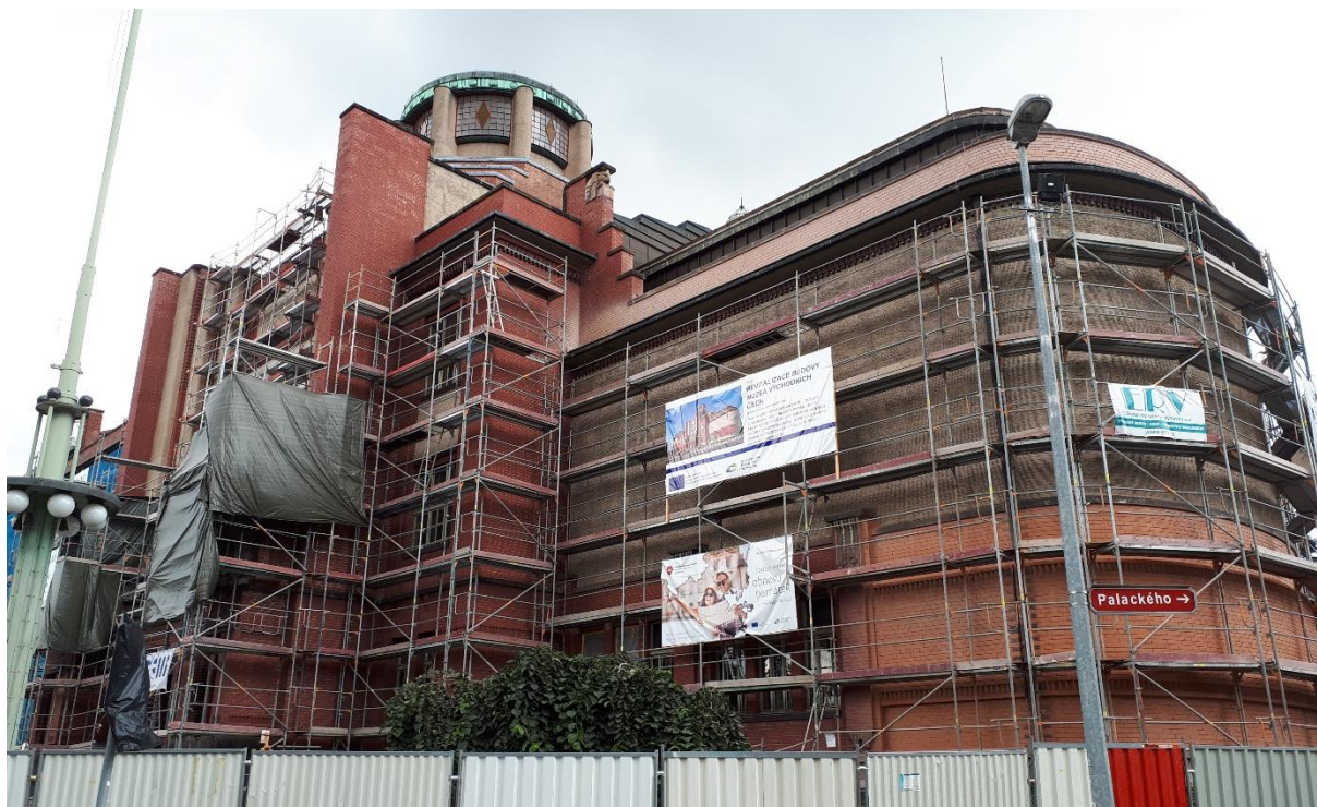
Obrázek 7: Probíhající revitalizace budovy Muzea východních Čech v Hradci Králové
